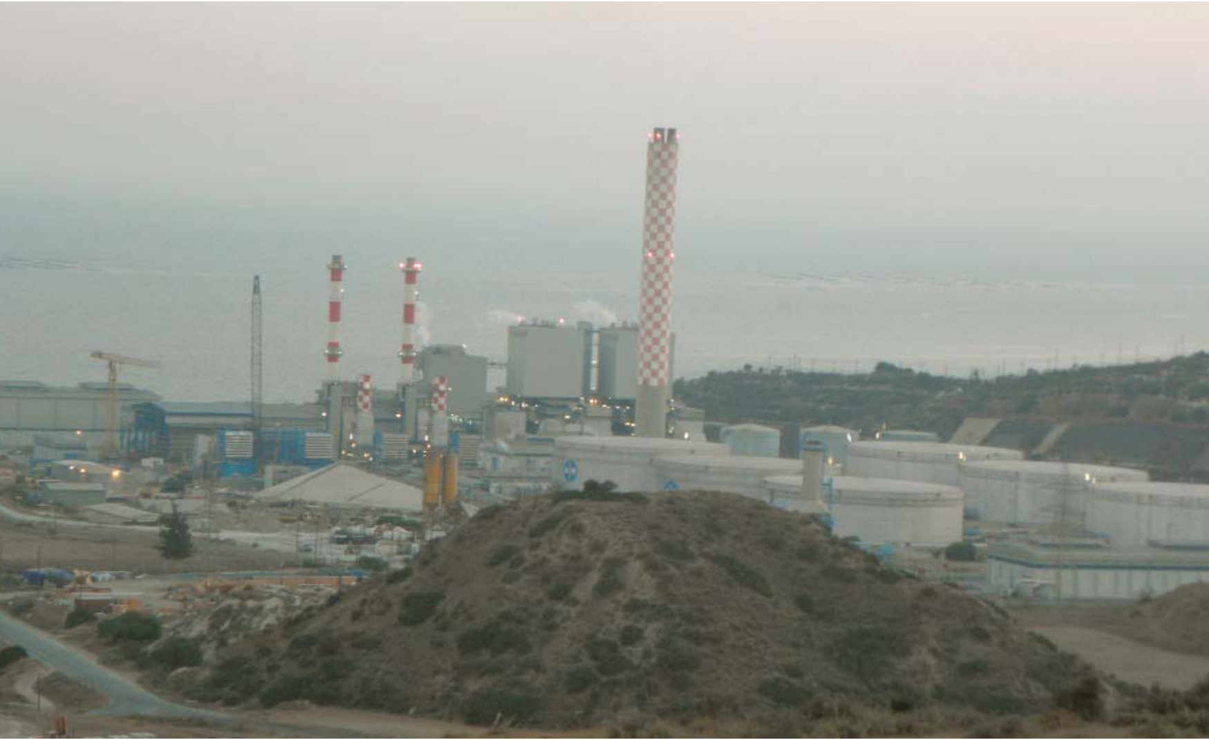
▲ Ηλεκτροπαραγωγικός Σταθμός Α.Η.Κ.
