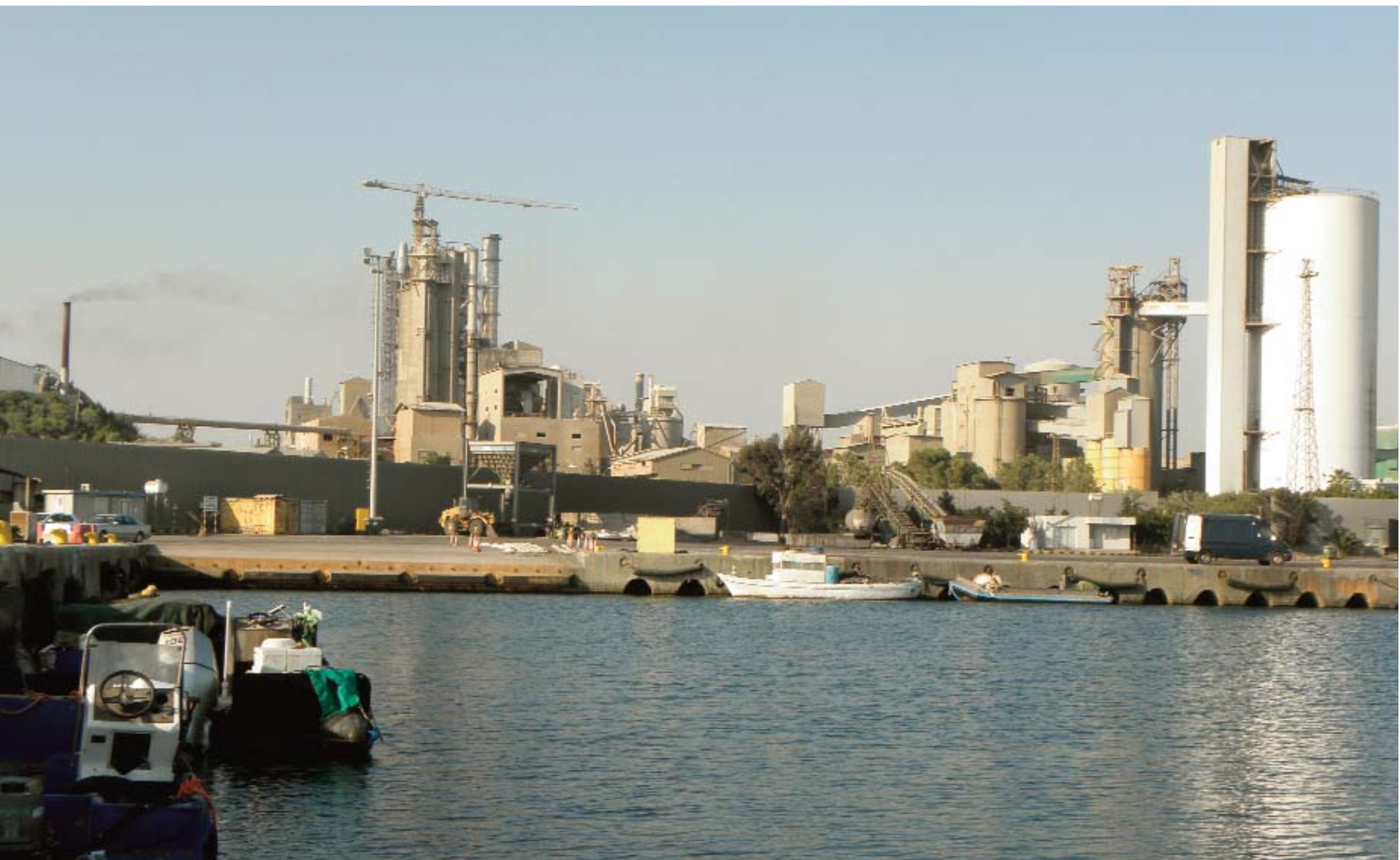
▲ Εγκαταστάσεις Τσιμεντοποιού Βασιλικού.
