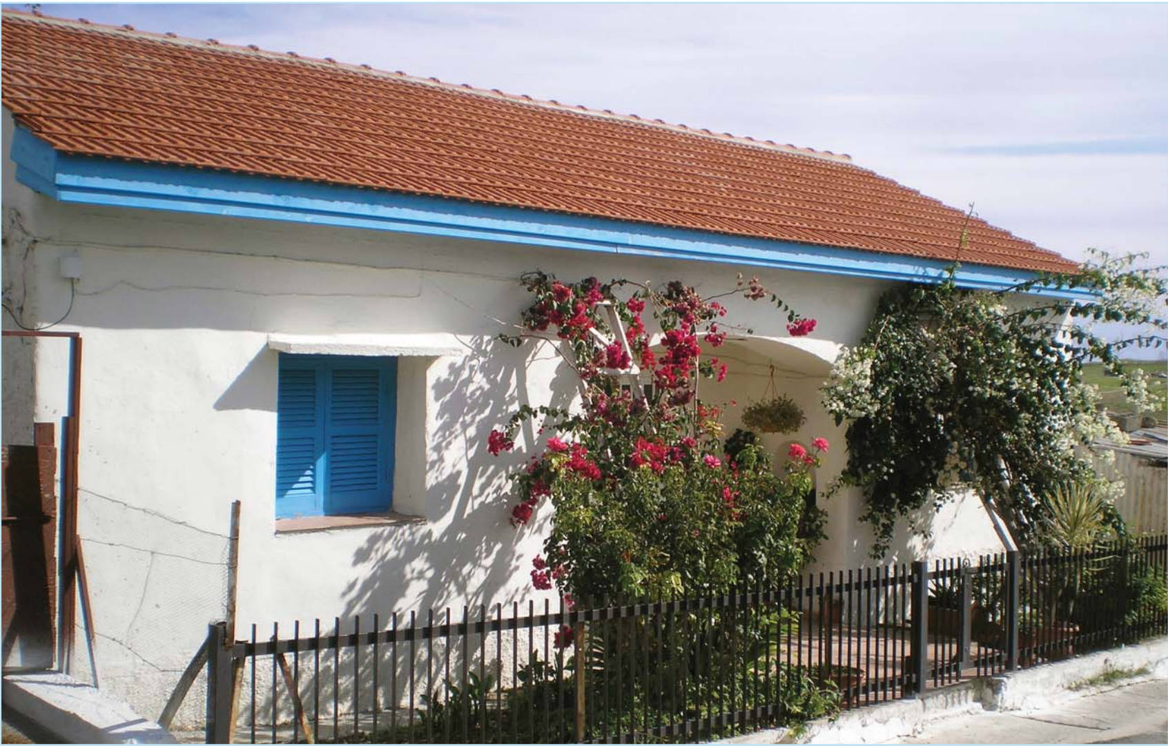
Σπίτι με καταπράσινο, περιποιημένο κήπο
